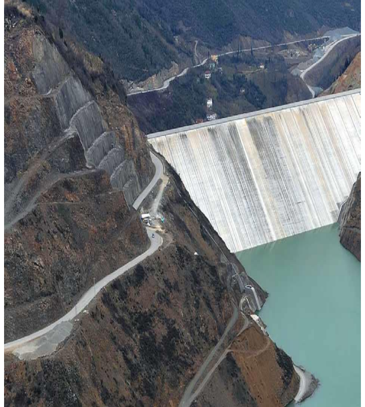
Kaynak: Çevre ve Şehircilik Bakanlığı (İDEP)
