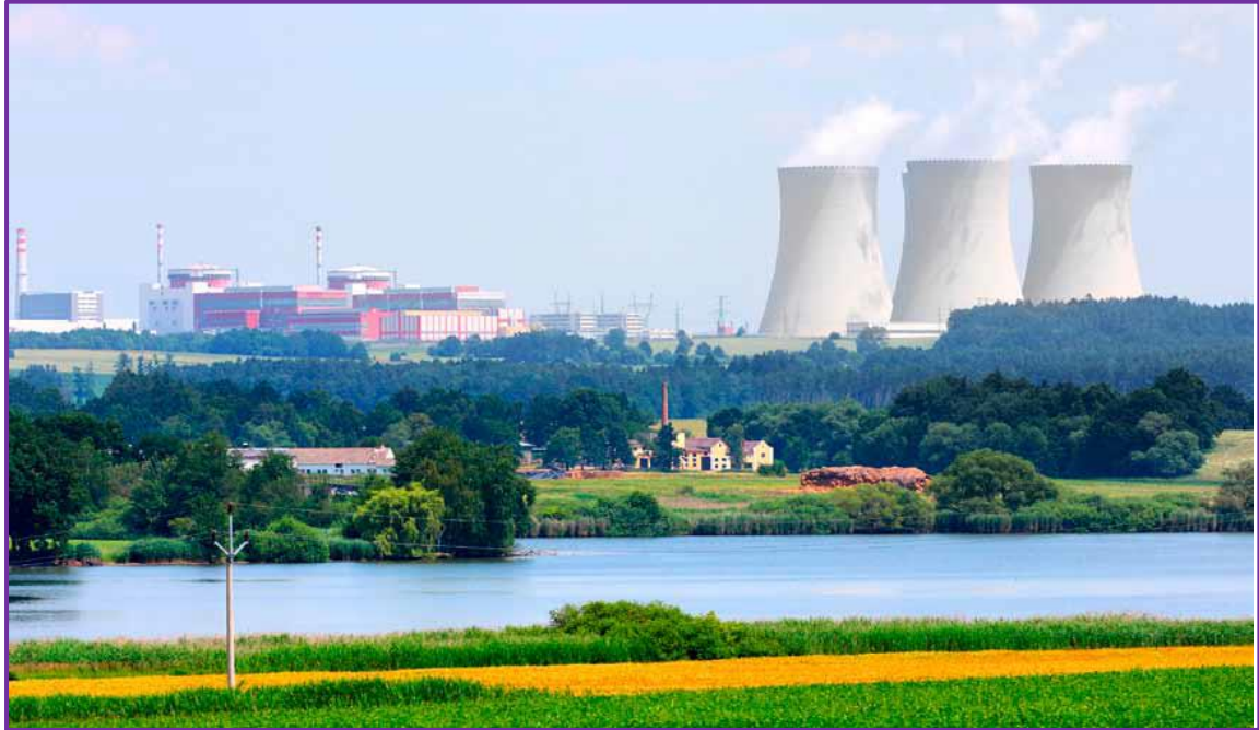
Kaynak: Çevre ve Şehircilik Bakanlığı (İDEP)
