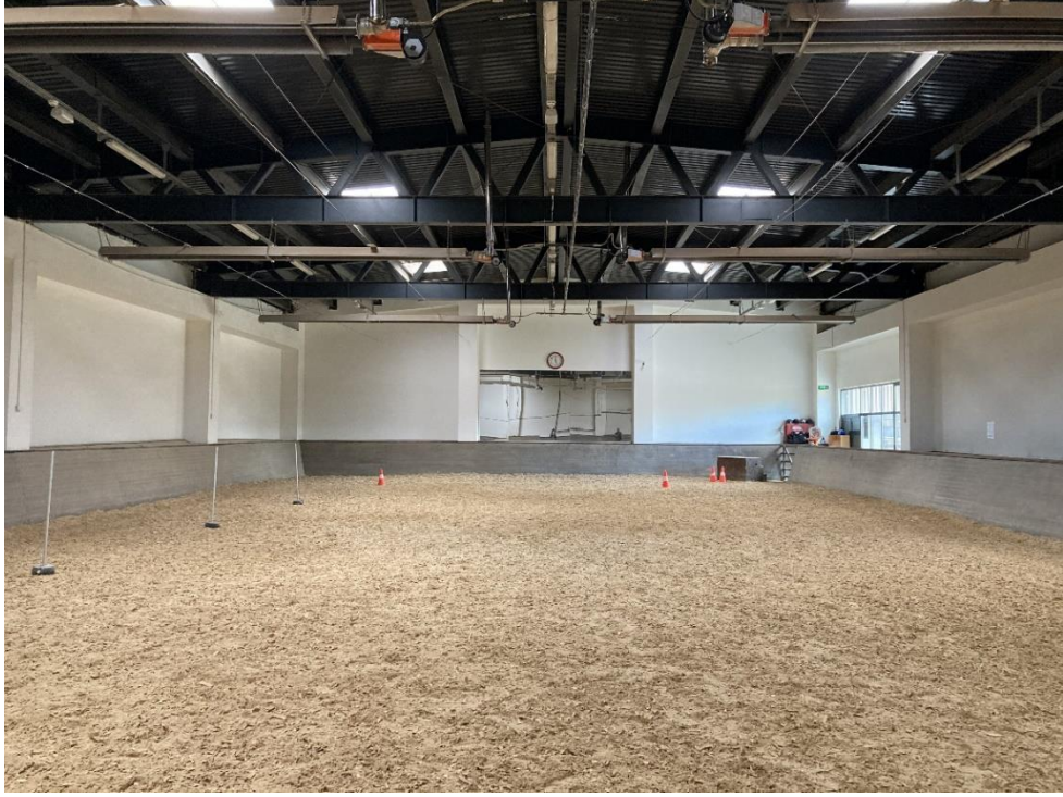
Şekil 42. Kapalı maneş genel görünüm
