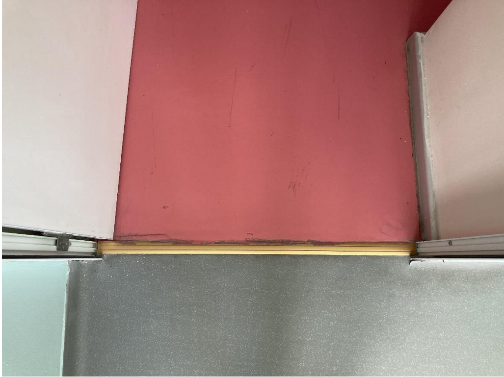
Şekil 48. Koridor ve sınıf geçişlerinde eşik kullanımı
