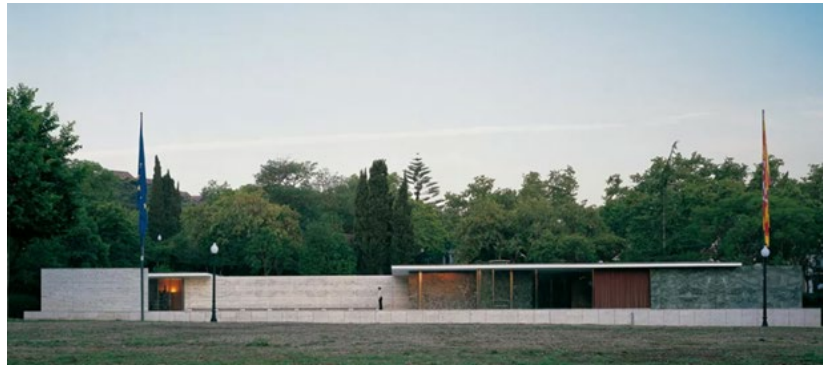
Şekil 6. Mies van der Rohe. Barselona Pavyonu, 1929.
