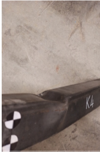
Şekil 49. Kare kesitli İBÇE kirişte oluşan yerel burkulmalar
