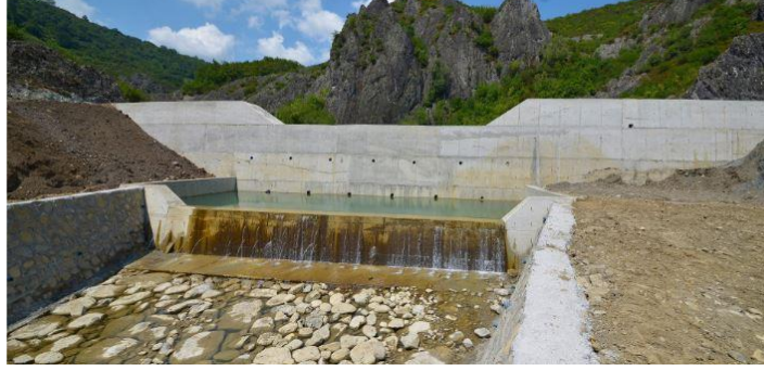
Şekil 1.16. Zonguldak Beycuma üzerinde inşa edilmiş tersip bent
