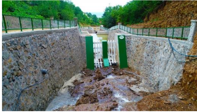
Şekil 1.17. Trabzon Kof Deresi üzerinde inşa edilmiş geçirgen tersip bent
