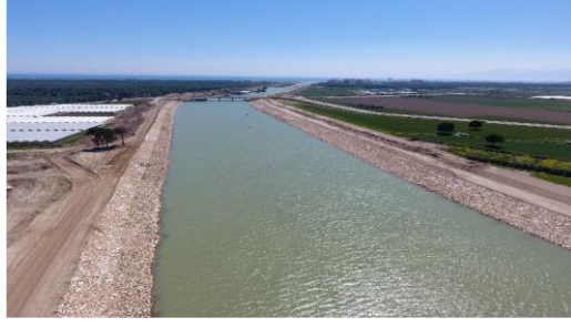
Şekil 1.13. Aksu çayında inşası tamamlanmış taşkın seddeleri
