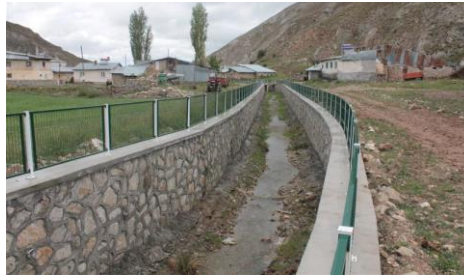
Şekil 1.15. Sivas Hafik Tuzhisar Köyü taşkın koruma kanalı inşaatı
