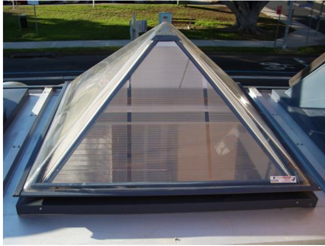
Şekil 11. Açısız seçici tavan penceresi uygulaması
