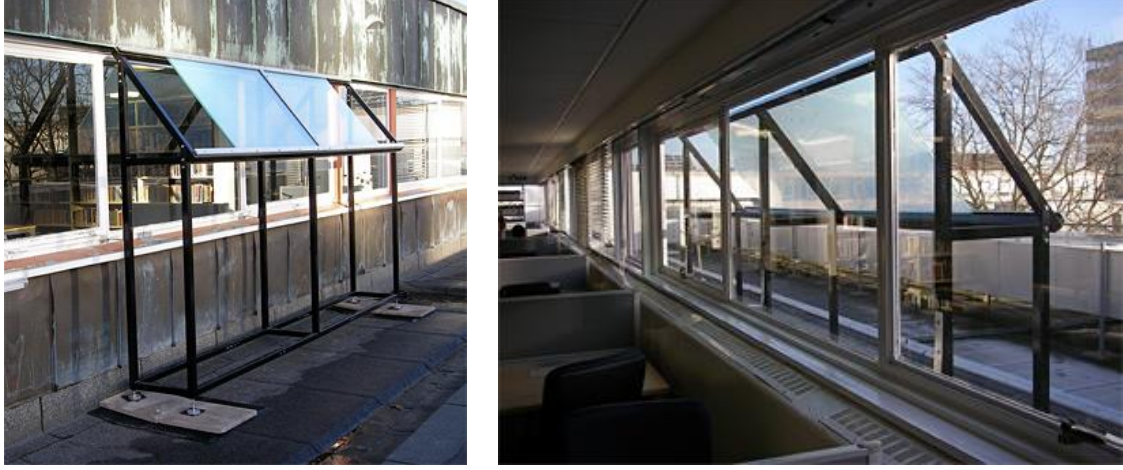
Şekil 14. HOE'li zenithal ışık yönlendirici cam uygulama örneği
