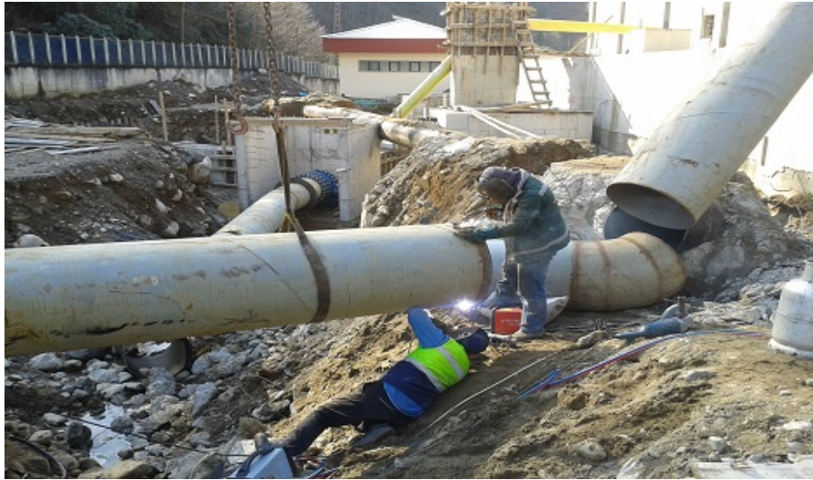
Şekil 1.9. Rize Andon HES Santraline Gelen Boru Hattı Çalışması [14]
