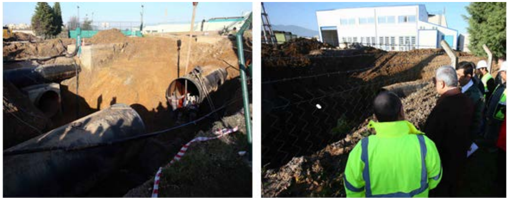
Şekil 1.3. Yuvacık HES Boru Hattı Çalışması Görüntüsü [12]
