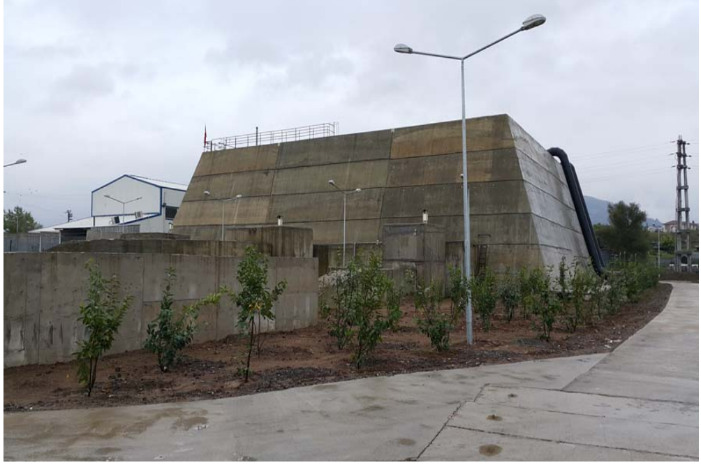
Şekil 1.4. Yuvacık HES Rezervuar Kısmı Görüntüsü [13]
