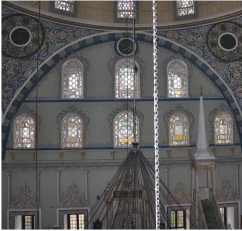
Fotoğraf : 19 – Güney Cephesi Alçı Vitrayların Görünümü İzzet Mehmet Paşa Camii
