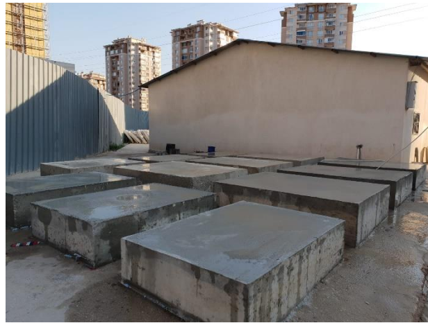
Şekil 5. Betonların Sulanması
