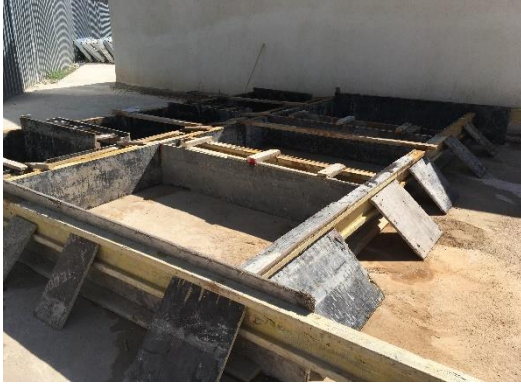
Şekil 3. C10 ve C30 Beton Kalıplarının Hazırlanması
