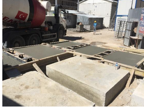
Şekil 4. C10 ve C30 Beton Dökümü
