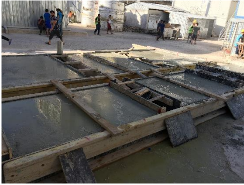
Şekil 4. C10 ve C30 Beton Dökümü
