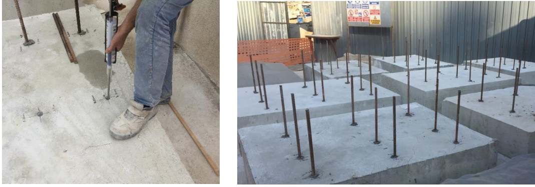
Şekil 8. Açılan Deliklere Donatı Ekilmesi
