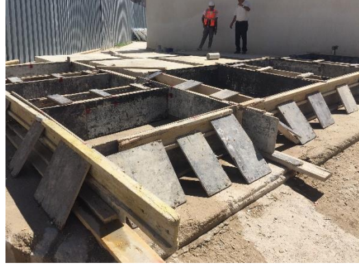
Şekil 3. C10 ve C30 Beton Kalıplarının Hazırlanması
