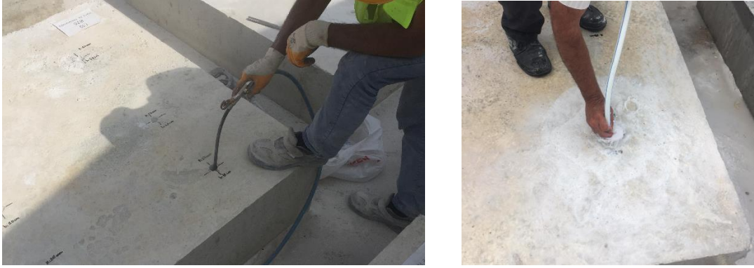
Şekil 7. Açılan Deliklerin Hava ve Su ile Temizlenmesi
