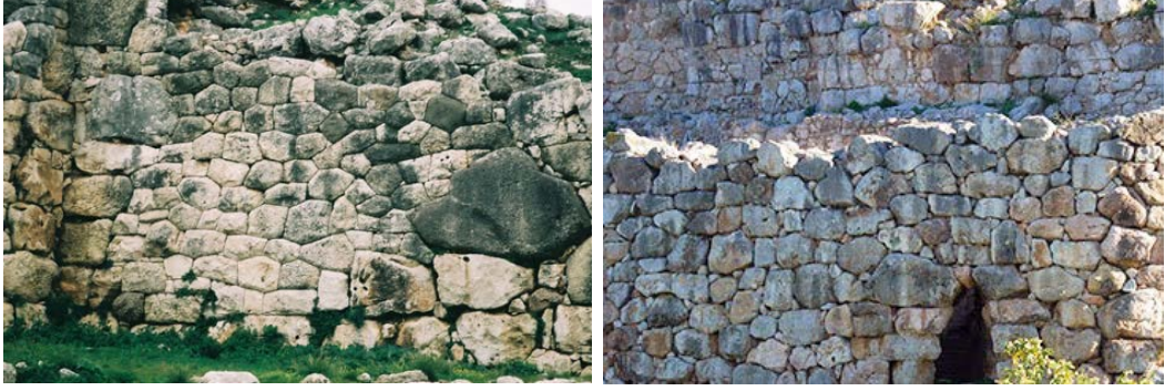
Şekil 1. Kyklopien duvar örme yöntemi (Cyclopean masonry)
