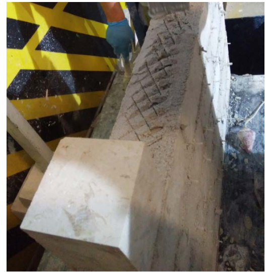
b) MSWLC duvarın detayı
