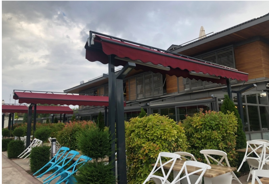
Şekil 59. Gazyađcı Furun Kebapçısı Ön Cephe Görünüm
