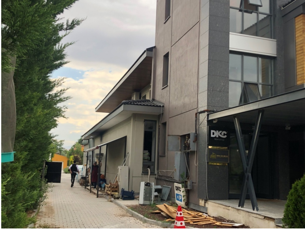
Şekil 56. Gazyağcı Furun Kebapçısı Arka Cephe Görünüm
