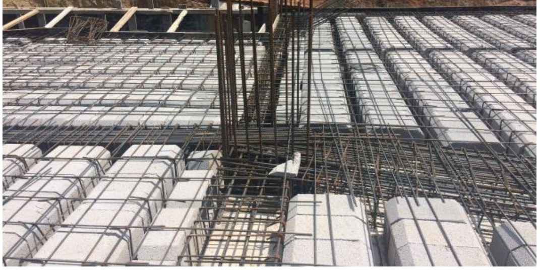
Şekil 17. Asmolen döşeme elemanı olarak bimsblok kullanımı
