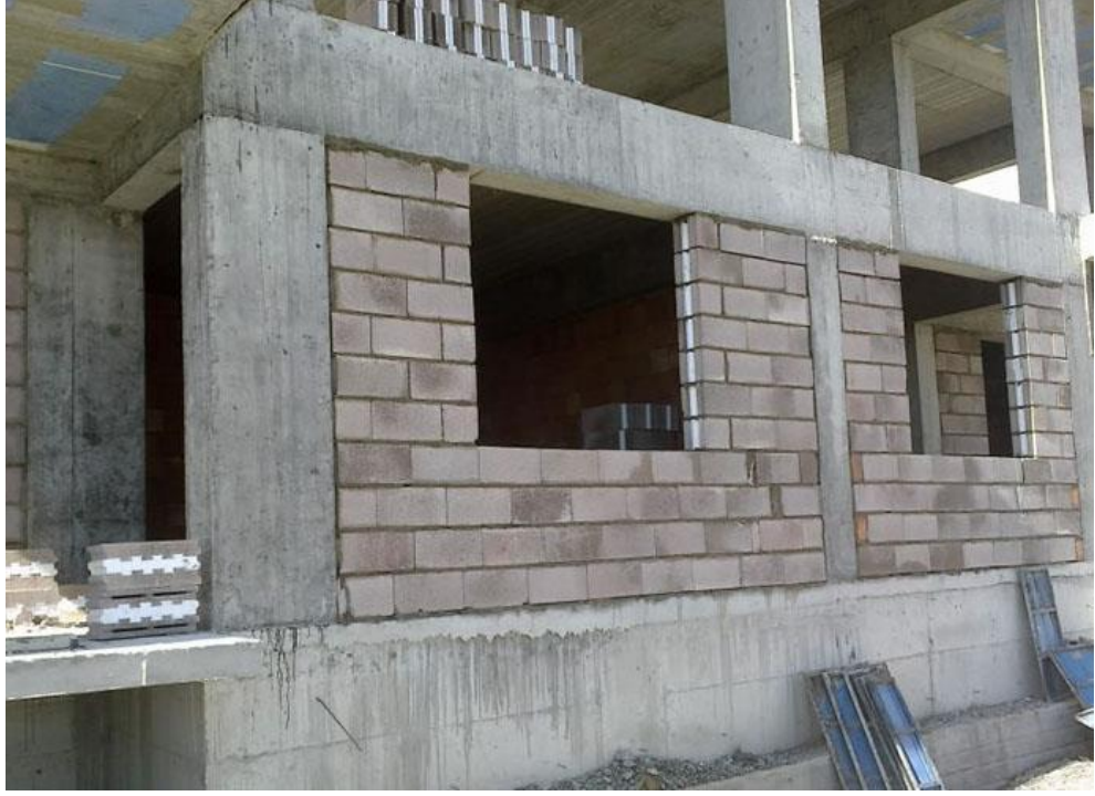
Şekil 16. Duvar elemanı olarak bimsblok kullanımı
