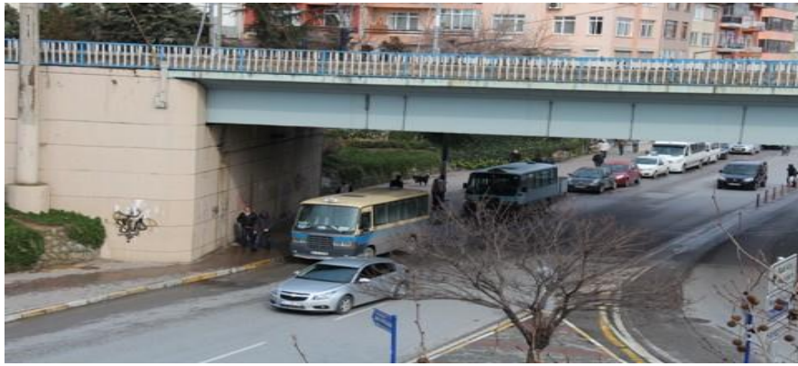
Şekil 34 Köprü Altı Yaya Kaldırımı (Url 10, t.y.)
