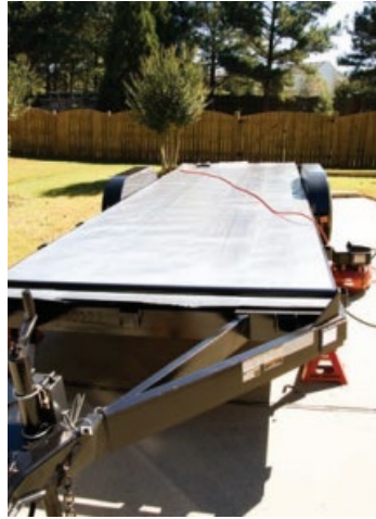
Şekil 31. Römork üzerine alüminyum sac kaplama uygulaması
