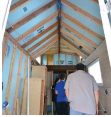
Şekil 40. Köpük levha yalıtım örneği
