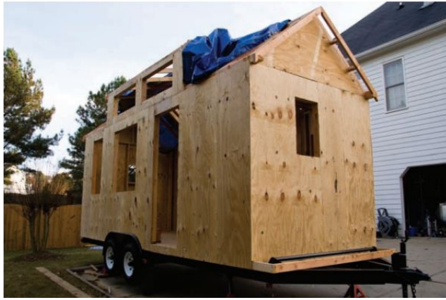
Şekil 36. Çerçeveleme sonrası kaplama örneği
