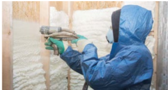
Şekil 42. Püskürtme yalıtım örneği
