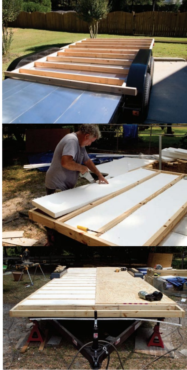
Şekil 32. Ahşap zemin çerçevesinin yapılması, yalıtım malzemesi üzerine kontrplak kaplanması
