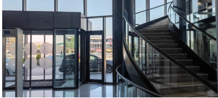
Şekil 60. Novotel çelik konsüriksiyonlu merdiven
