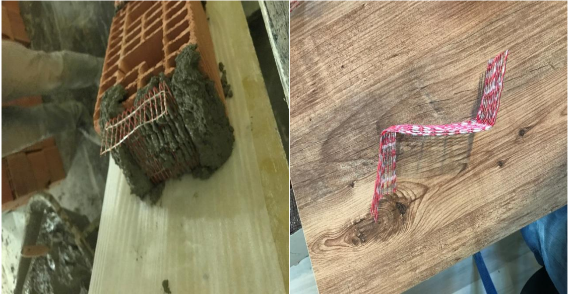
Şekil 21. Yığma Tuğla Dizilim-5'ün Yapımı
