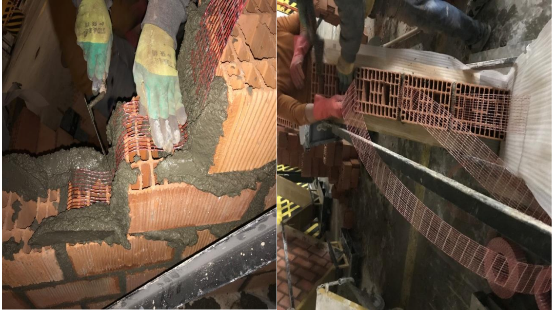
Şekil 19. Yığma Tuğla Dizilim-4'ün Yapımı
