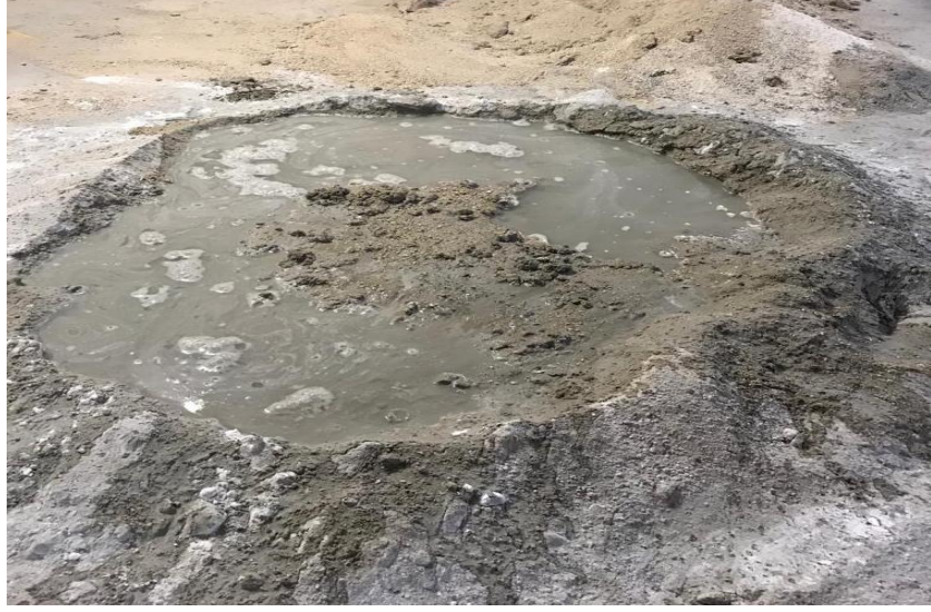
Şekil 6. TS 2510'dan seçilen duvar harcı karışımının yapılışı
