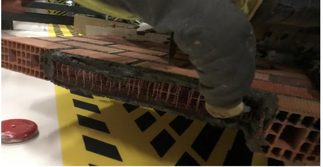
Şekil 17. Yığma Tuğla Dizilim-3'ün Yapımı
