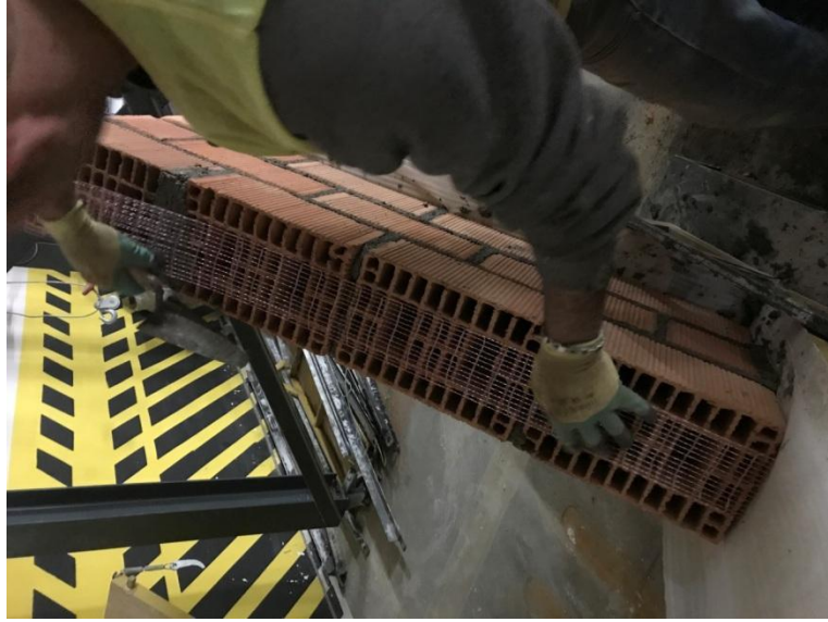
Şekil 13. Yığma Tuğla Dizilim-1'in Yapımı
