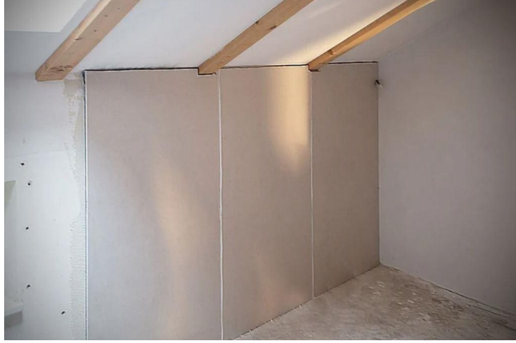
Şekil 42. Aerogips alçı panelini iç duvarda termal yalıtım uygulaması
