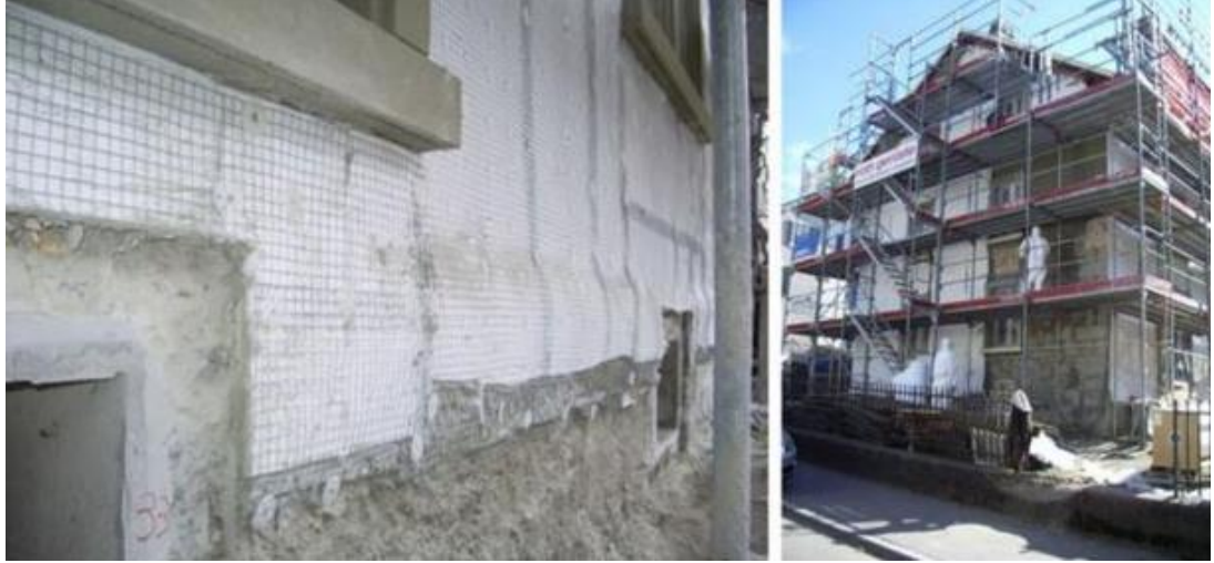
Şekil 39. Spaceloft battaniyeleri ile dış cephe duvar yalıtımı montaj uygulaması
