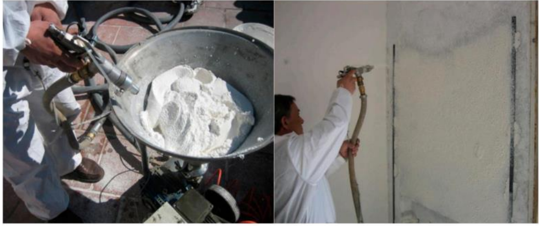
Şekil 34. Silika aerojel takviyeli sıvaların yerinde uygulaması
