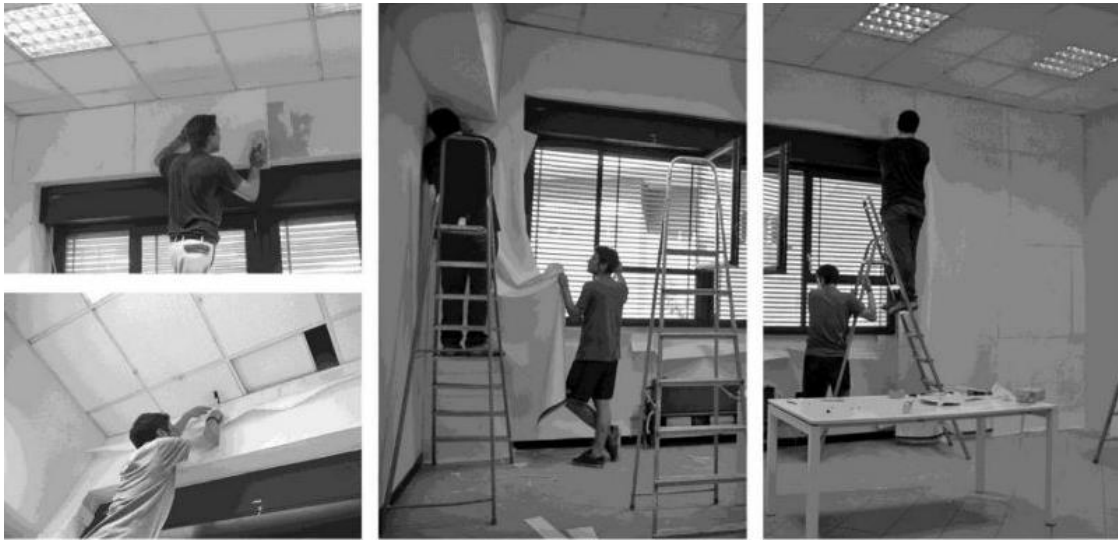
Şekil 44. Aerojel bazlı tekstil duvar kâğıdının uygulanması
