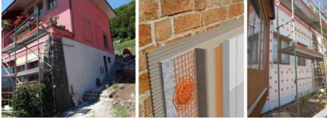
Şekil 41. Aerocalce arojel battaniye yalıtım sistemi ile binanın yalıtımının güçlendirilmesine ait örnekler. (a) binanın önden ve yandan görünümü (b) Aerocalce sisteminin katmanlı yapısının enine kesiti (c) zemindeki duvar ve pencere detayları
