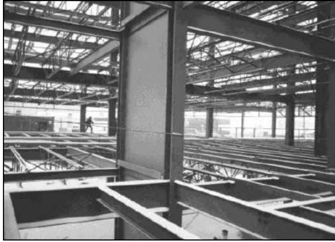
Şekil 1. Kanada'da yapılan 6 katlı çelik levhalı yapı
