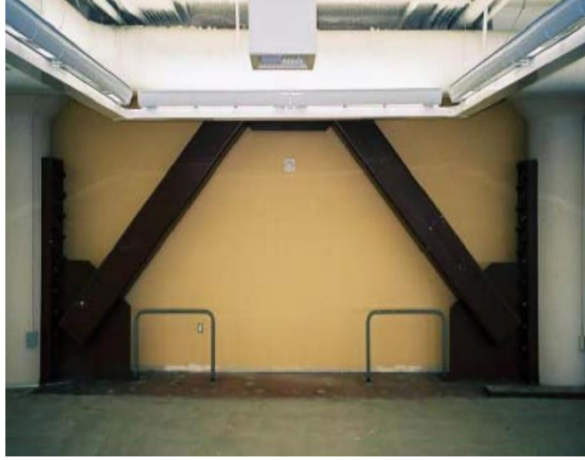
Şekil 3. Çelik çapraz ile güçlendirme yapılan yapı
