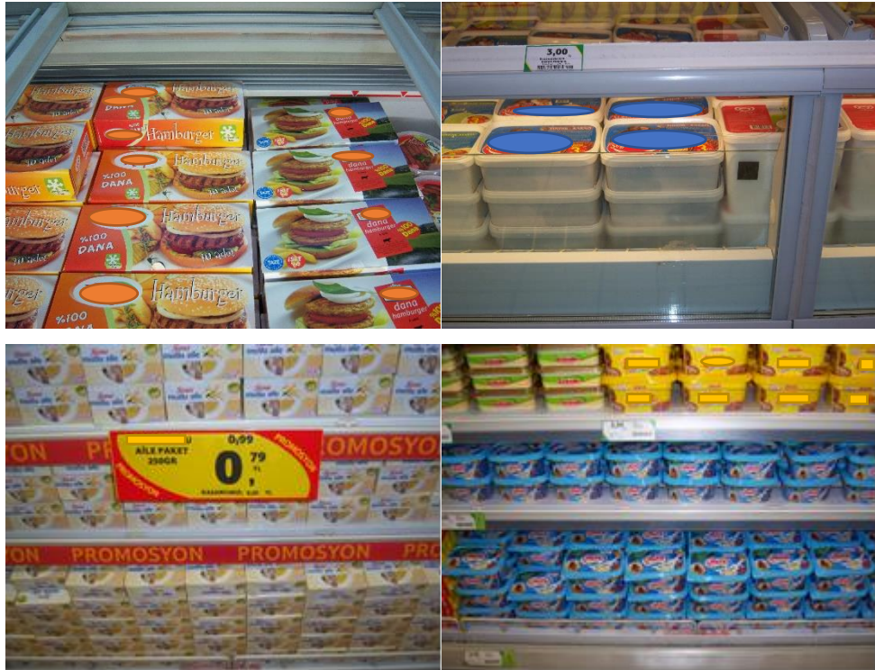
Şekil 26. Hava ızgarası önüne yapılan yanlış dolum şekli
