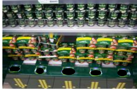
Şekil 17. Ticari gereçler ile engellenmiş hava perdeleri
