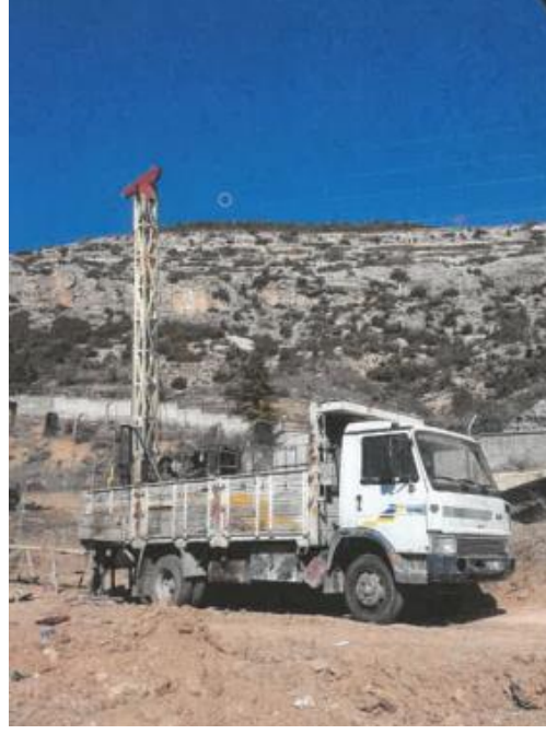
Şekil 10. Ermenek 112 ada 33 parseldeki sondaj çalışmaları
