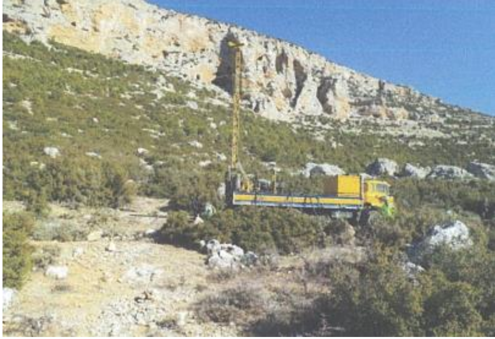
Şekil 56. Ermenek 109 ada 81 parseldeki sondaj çalışmaları
