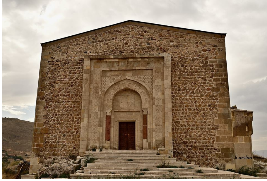
Şekil 1. Divriği kale camii kapı
