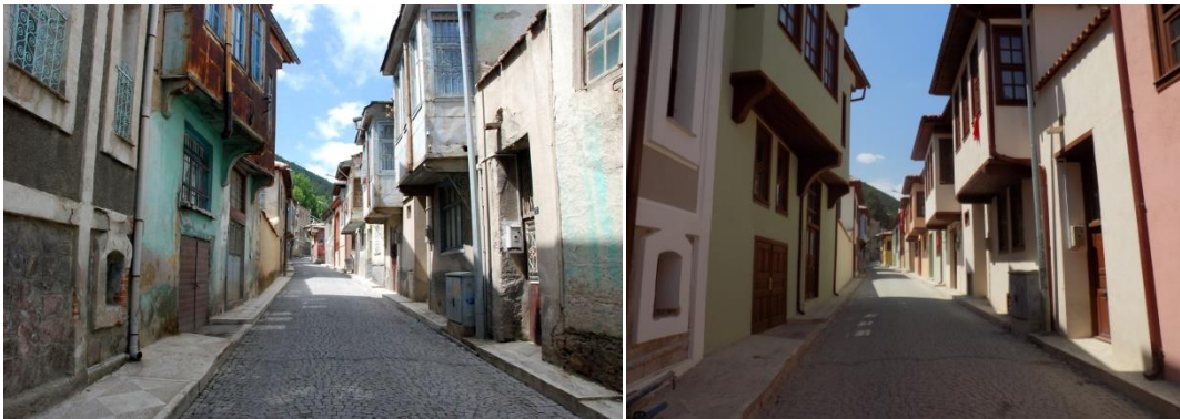
Resim 4.5: Akşehir Evleri Sokak Sağlıklaştırma Çalışmaları (Akşehir Belediyesi)
